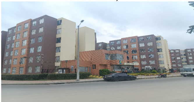
Fachada del Conjunto
