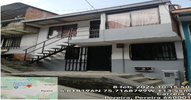
Fachada del Inmueble
