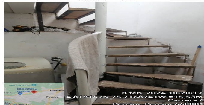
Escalera del inmueble
