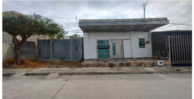
Fachada del Inmueble
