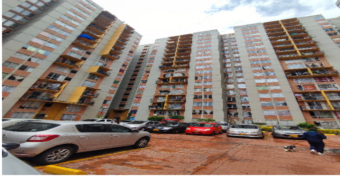
Fachada del Inmueble
