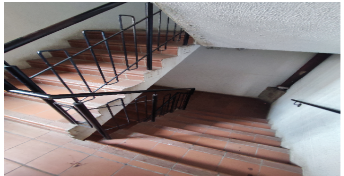
Escalera común - CJ
