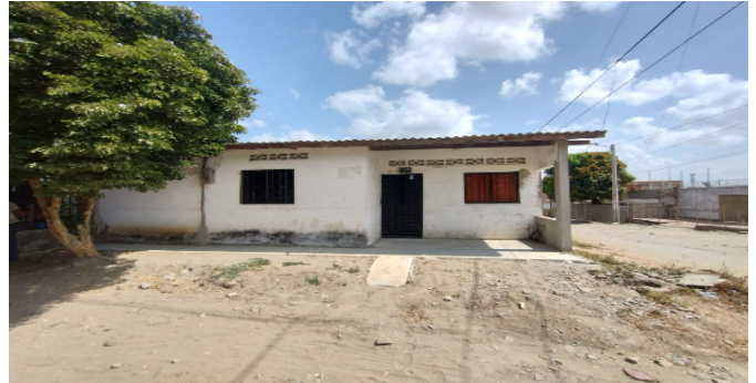
Fachada del Inmueble
