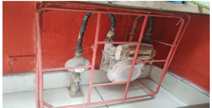
Contador de Gas
