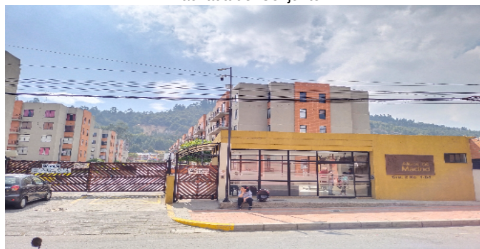
Fachada del Conjunto
