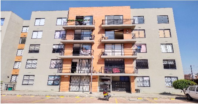
Fachada de la torre
