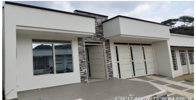
Fachada del Inmueble
