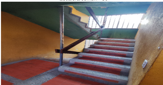
Escalera común - CJ
