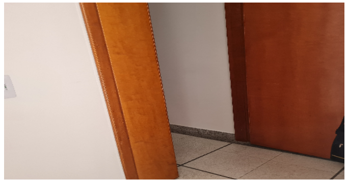
Detalle de acabados
