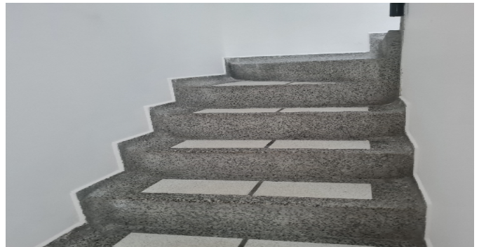
Escalera común - CJ
