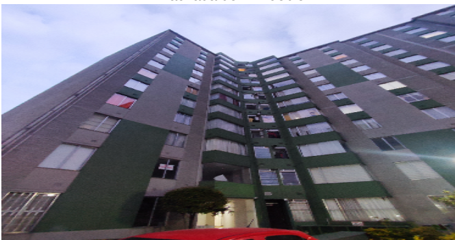
Fachada del Inmueble
