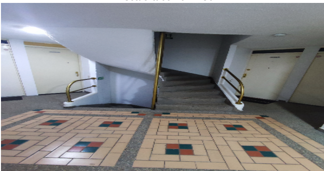
Escalera común - CJ
