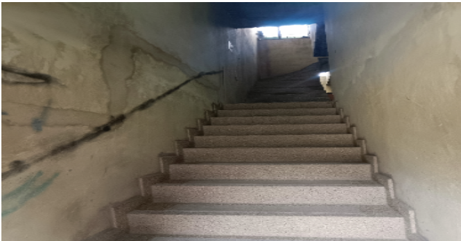
Escalera del inmueble
