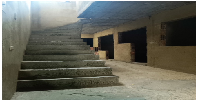
Escalera del inmueble
