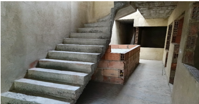
Escalera del inmueble
