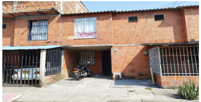
Fachada del Inmueble
