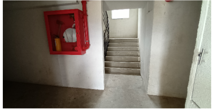
Escalera común - CJ
