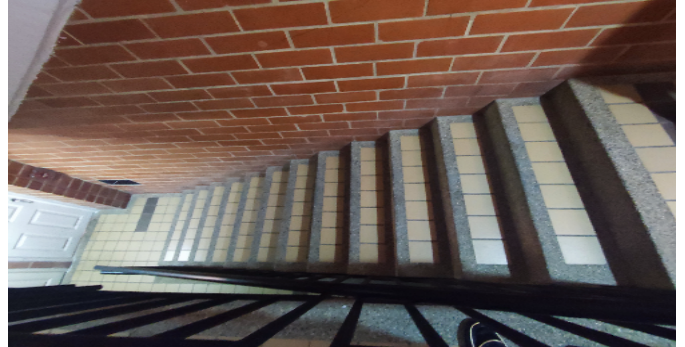
Escalera común - CJ
