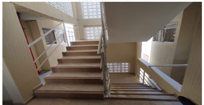
Escalera común - CJ
