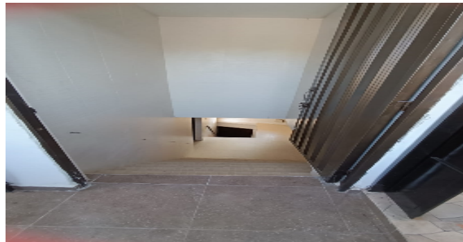
Escalera común - CJ
