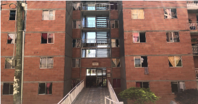
Fachada del Inmueble
