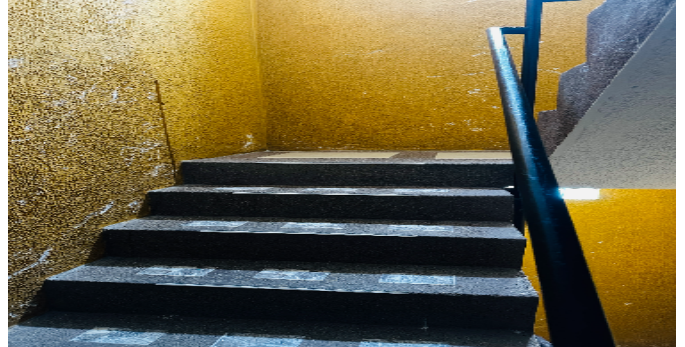
Escalera común - CJ
