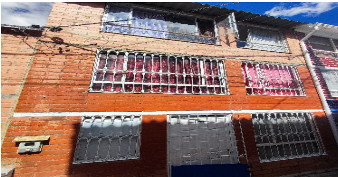
Fachada del Inmueble
