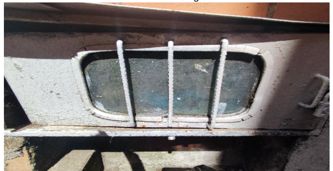
Contador de Agua
