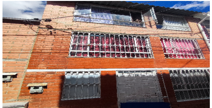
Fachada del Inmueble
