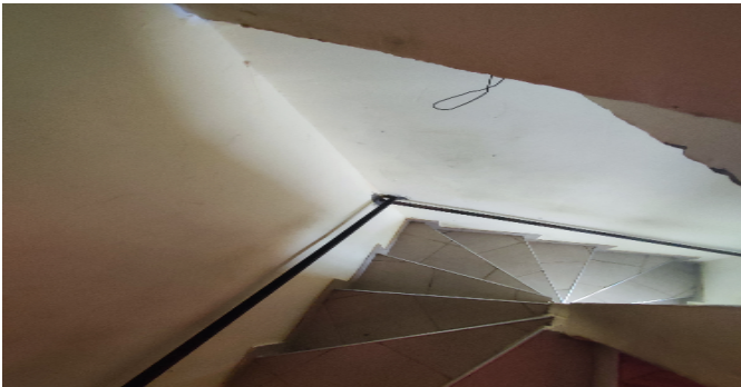
Escalera del inmueble
