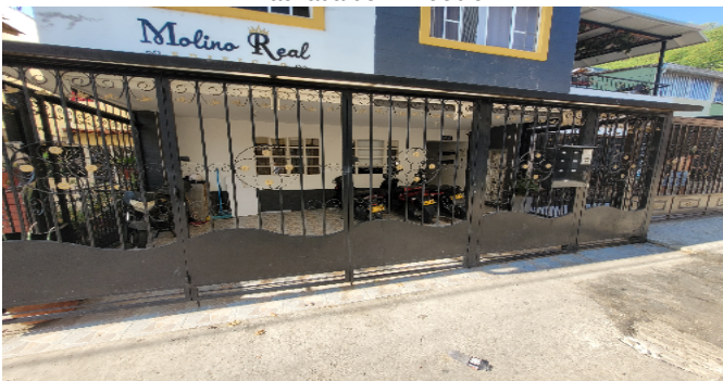
Fachada del Inmueble
