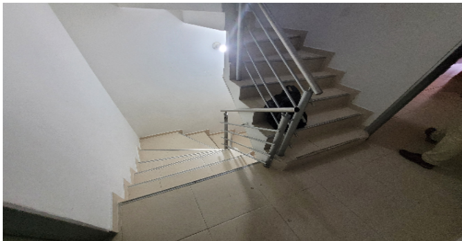
Escalera común - CJ
