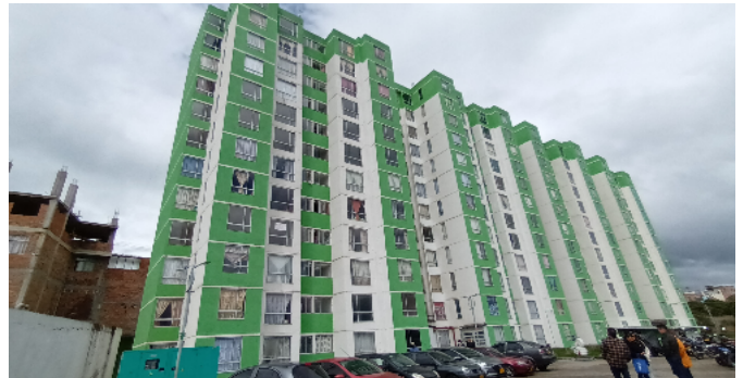
Fachada del Inmueble
