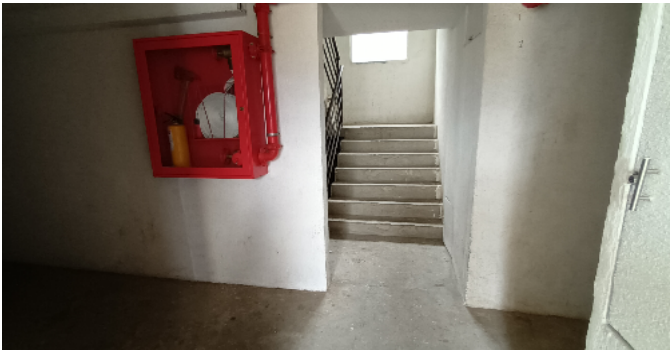
Escalera común - CJ
