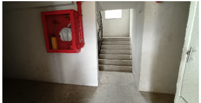
Escalera común - CJ
