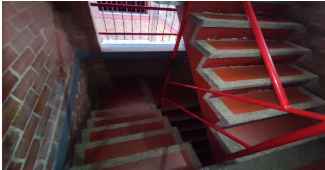
Escalera común - CJ
