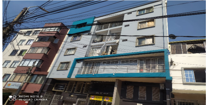
Fachada del Inmueble
