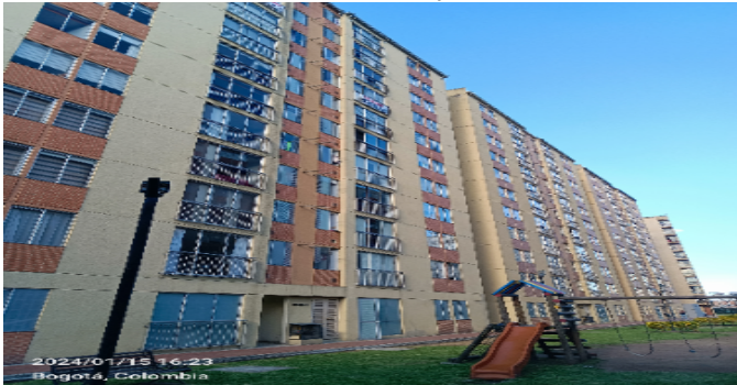
Fachada del Conjunto
