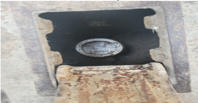
Contador de Agua
