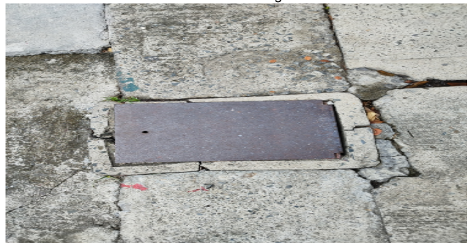
Contador de Agua
