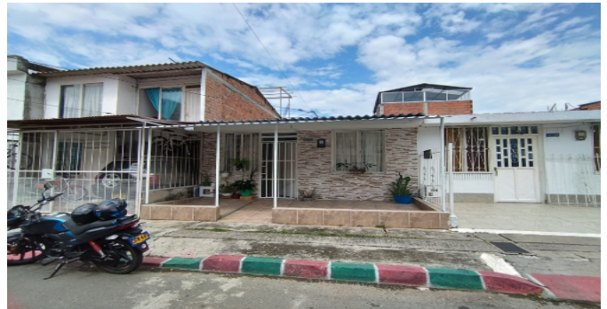
Fachada del Inmueble
