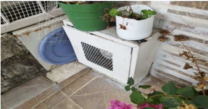
Contador de Gas
