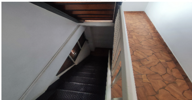
Escalera común - CJ
