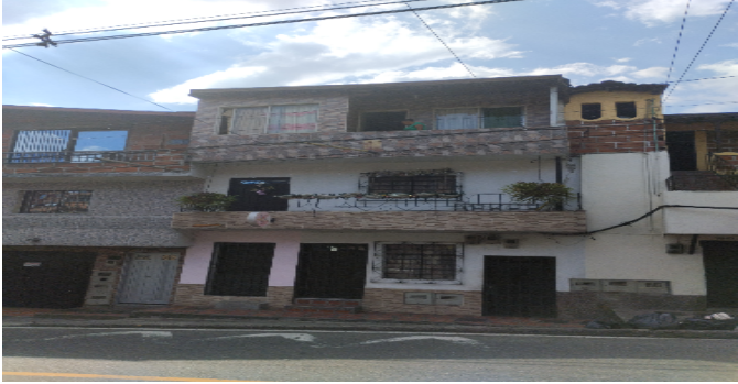
Fachada del Inmueble
