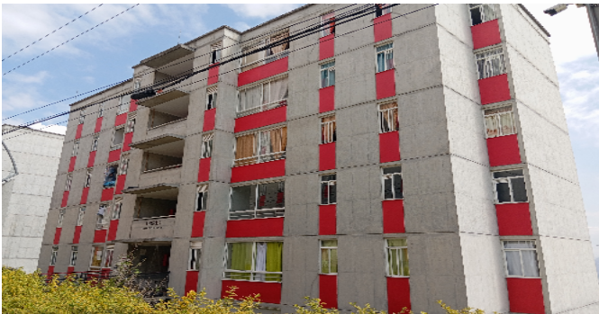
Fachada del Inmueble
