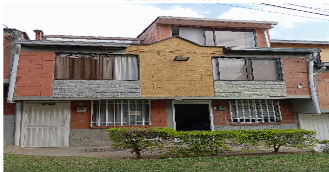
Fachada del Inmueble
