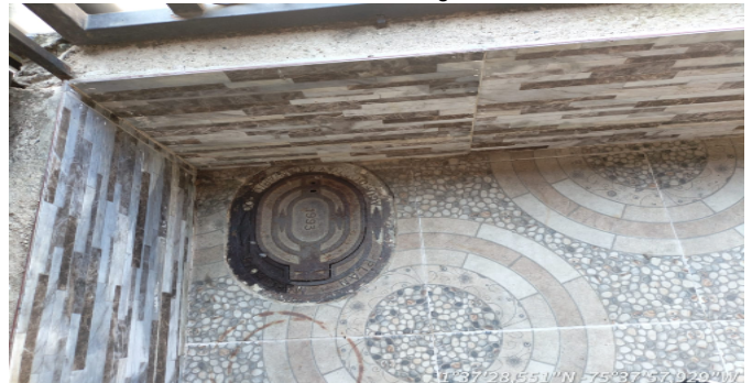
Contador de Agua
