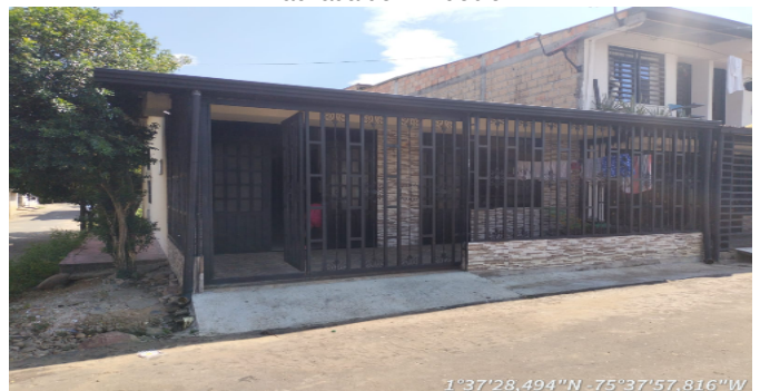
Fachada del Inmueble
