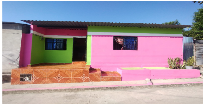
Fachada del Inmueble
