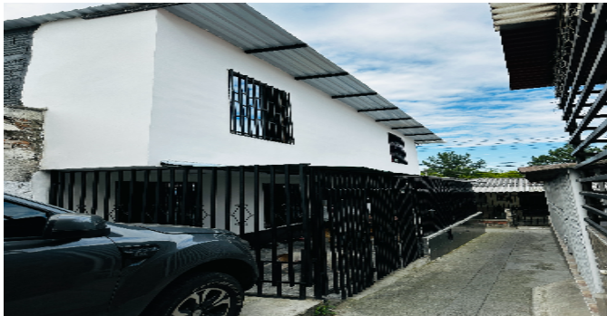
Fachada del Inmueble
