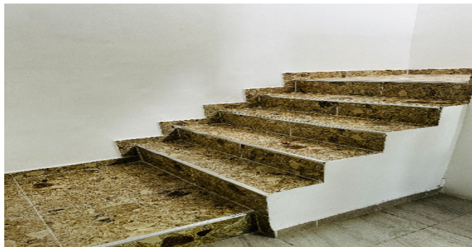
Escalera del inmueble
