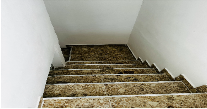
Escalera del inmueble
