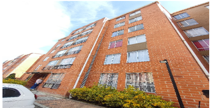
Fachada del Inmueble
