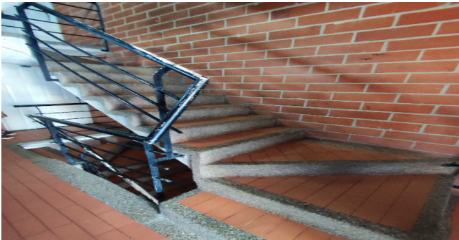
Escalera común - CJ
