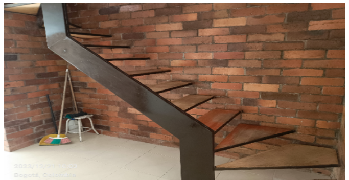
Escalera del inmueble
