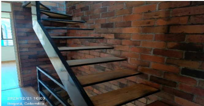
Escalera del inmueble
