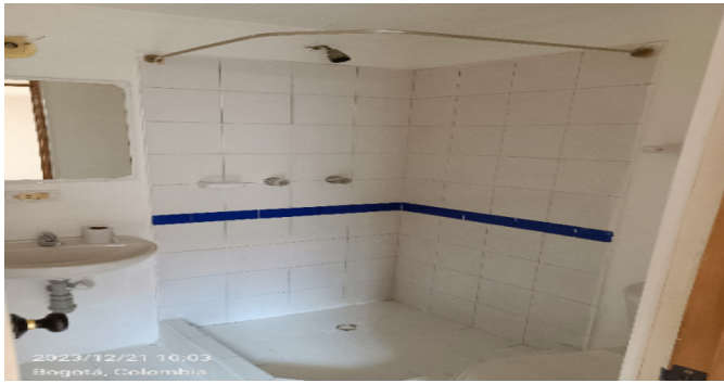
Baño Privado Hab 1
