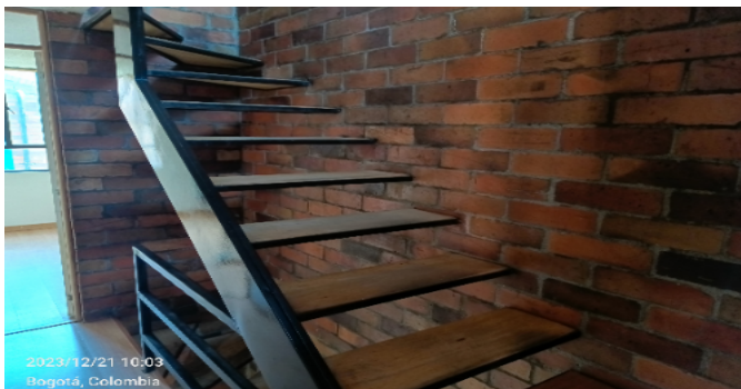
Escalera del inmueble
