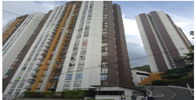
Fachada del Inmueble
