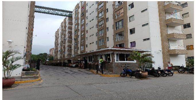
Fachada del Inmueble
