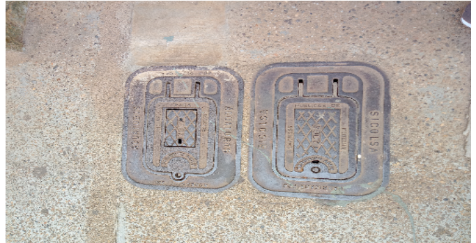
Contador de Agua
