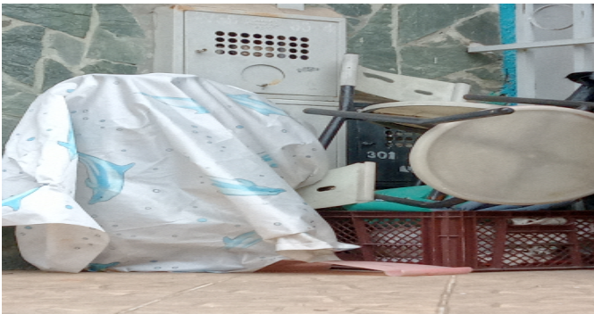
Contador de Gas
