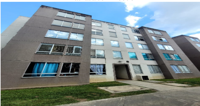
Fachada del Inmueble
