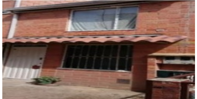
Fachada del Inmueble
