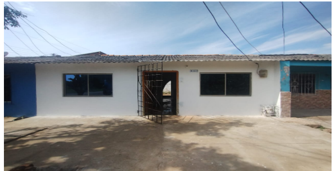
Fachada del Inmueble
