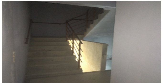
Escalera común - CJ
