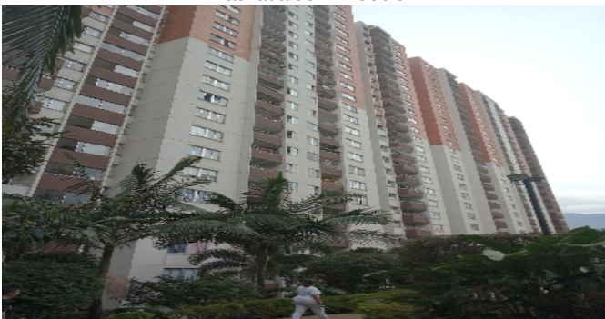
Fachada del Inmueble
