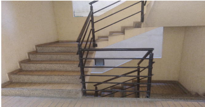
Escalera común - CJ
