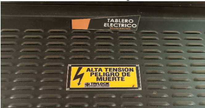
Contador de Energia
