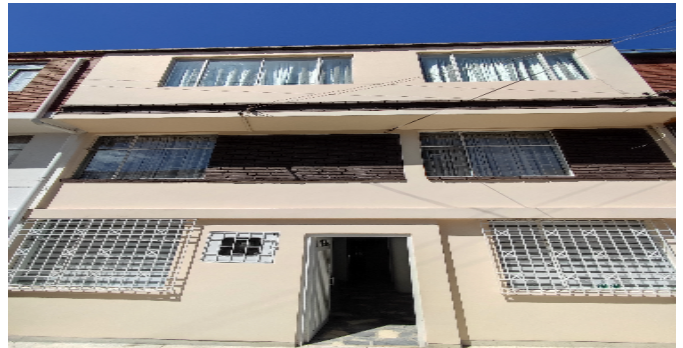
Fachada del Inmueble
