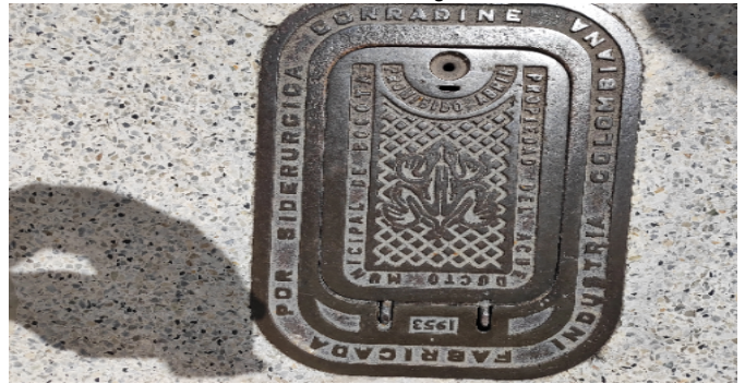
Contador de Agua
