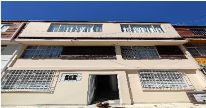
Fachada del Inmueble
