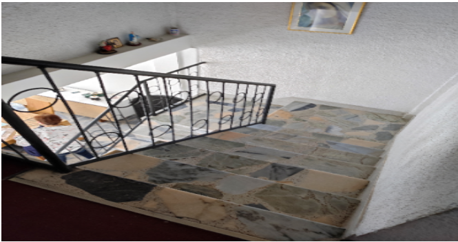
Escalera del inmueble
