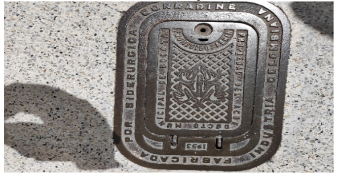
Contador de Agua
