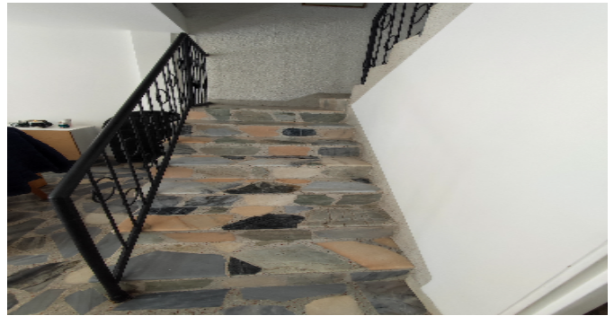
Escalera del inmueble
